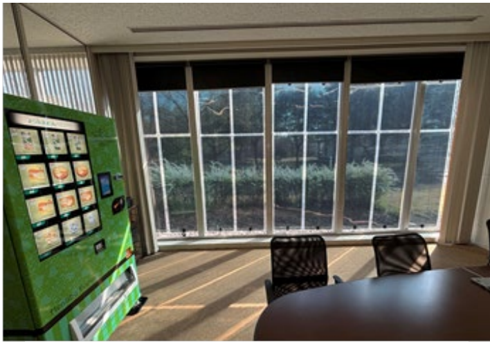
実装した ST-OPV モジュールと S D R S 製自販機
